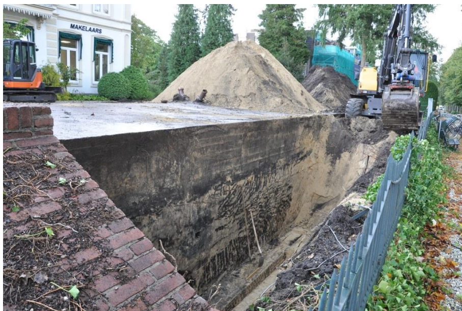
Foto 13. Restauratie bunker Seyss Inquart.
